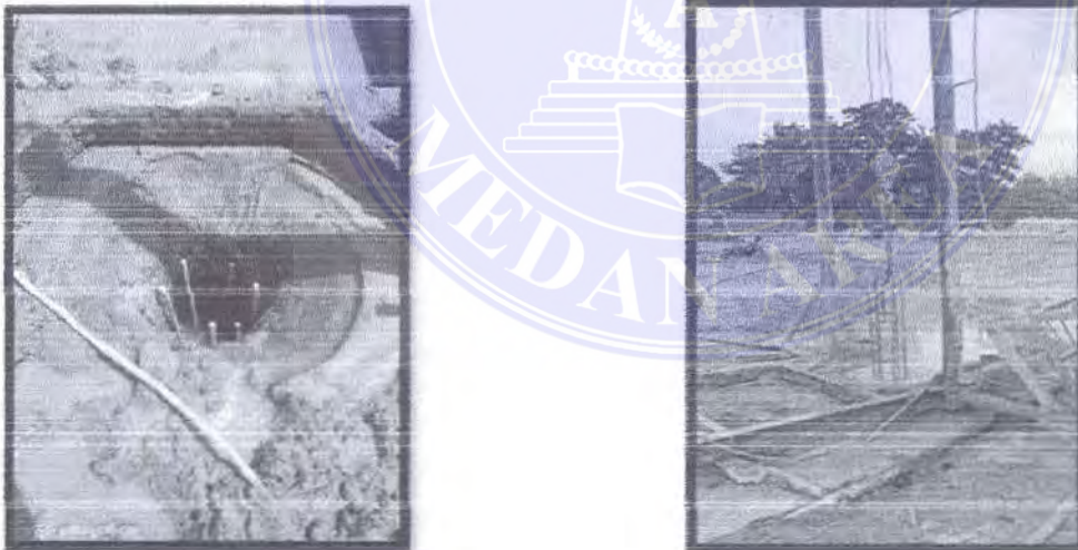
Gambar.11 Pencabutan casing
