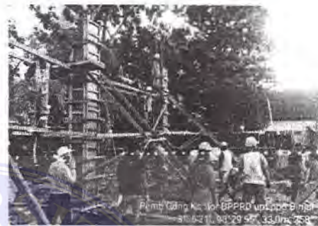
Gambar 3. Penuangan cor beton Kedalam bekisting kolom
