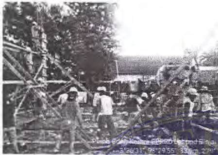
Gambar 2. Penuangan cor beton dari truk molen ke tuangan
