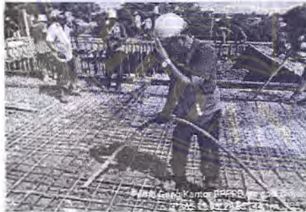
Gambar 13. pekerja sedang menuangkan spesi beton
