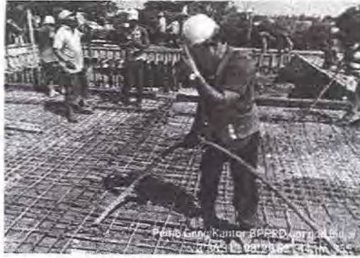
Gambar 8. Pengecoran Balok dan Plat Lantai
