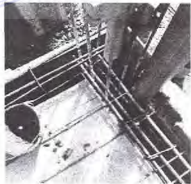
Gambar 5. Pembesian sudah dipasang
