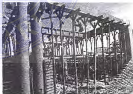
Gambar 7. Struktur Bekisting
