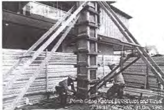
Gambar 2. Pengerjaan Bekisting
