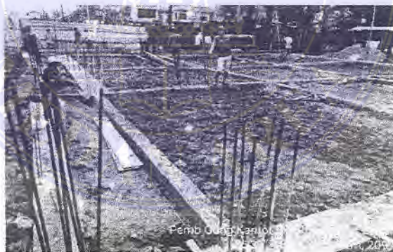
Gambar 1. pengerjaan kolom
