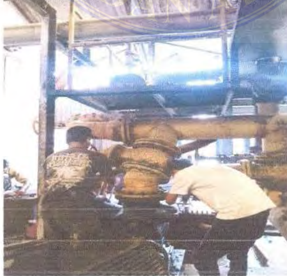
Gambar 3. 31 Perbaikan & Assembly Pompa Screw
