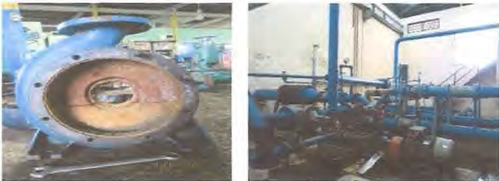
Gambar 3.12 Pompa Sentrifugal
