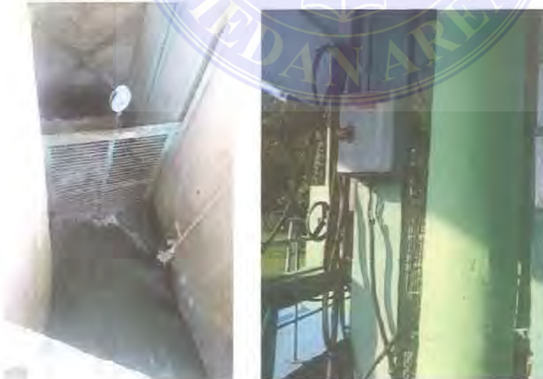
Gambar 3.1 Kondisi Eksisting Mulut Intake dan Penggerak Electromotor
