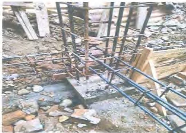
Gambar 3. Pemasangan Tulangan Kolom
