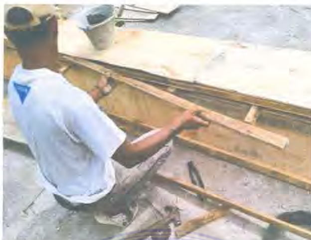
Gambar 4. Pemasangan Bekisting Kolom
