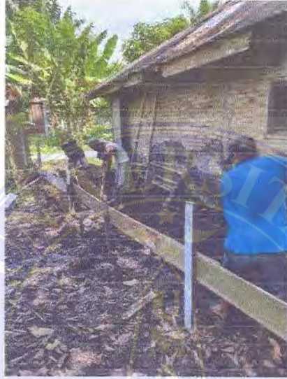
Gambar 3.1. Pemasangan Bowplank.
