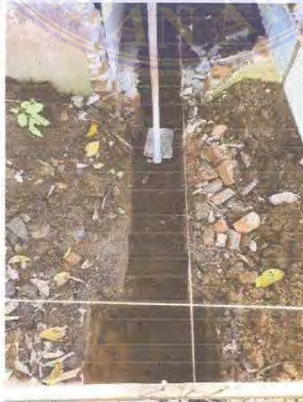
Gambar 3.2. Penggalian lubang pondasi tapak dan jalur sloof.
