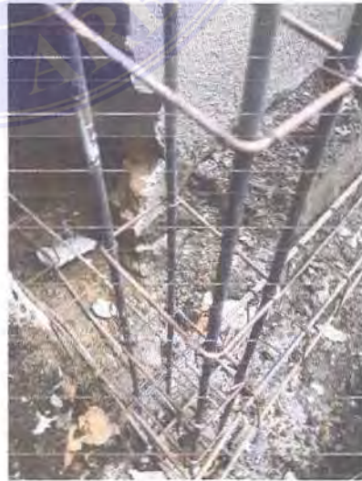
Gambar 3.4. Pemasangan besi pada pondasi tapak dan sloof.
