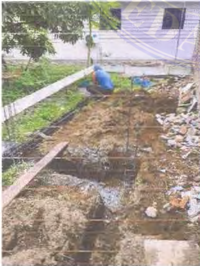
Gambar 3.4. Pemasangan besi pada pondasi tapak dan sloof.
