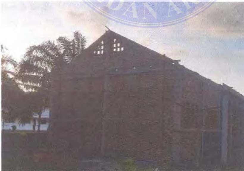
Gambar 3.12. Pekerjaan Tembok Layar
