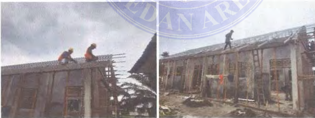
Gambar 3.18. Pekerjaan Pemasangan Kuda-Kuda Baja Ringan
