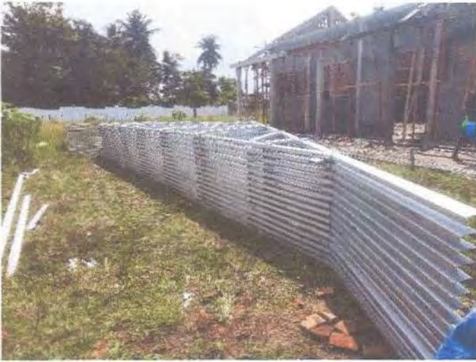
Gambar 3.16. Pekerjaan Perakitan Rangka Atap Kuda-Kuda Baja Ringan
