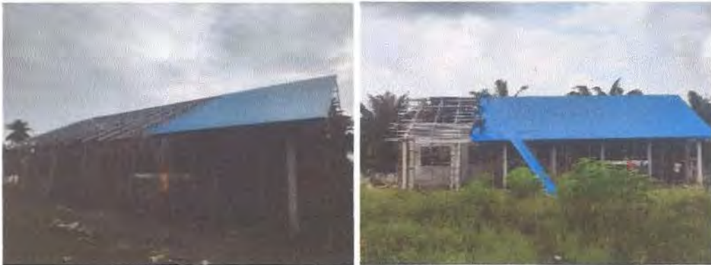
Gambar 3.19. Pekerjaan Atap Spandek
