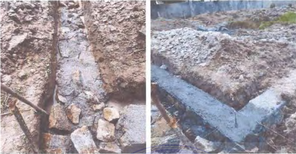
Gambar 3.5. Pekerjaan Pasangan Pondasi Batu Belah atau Pondasi Penerus
