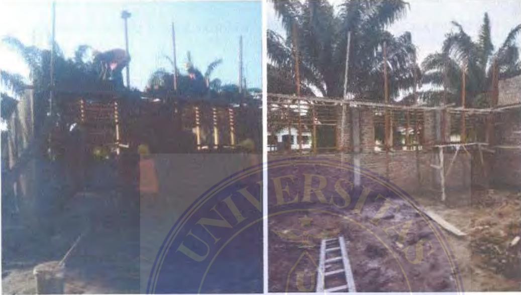
Gambar 3.11. Pekerjaan Ring Balok
