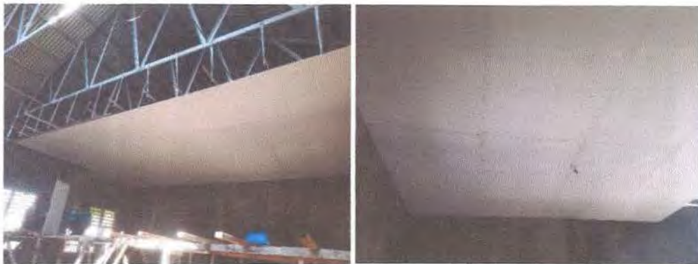
Gambar 3.21. Pekerjaan Plafond Gypsum
