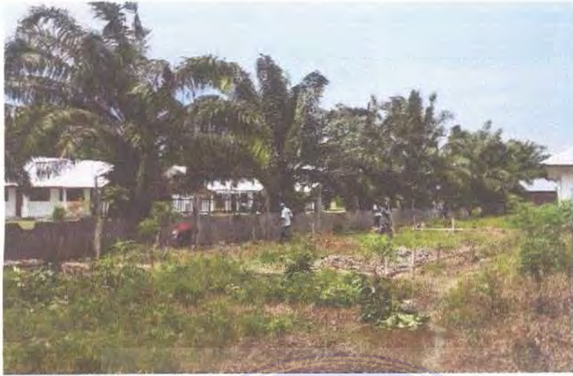
Gambar 3.2. Pengukuran dan Pembersihan Lokasi Pekerjaan
