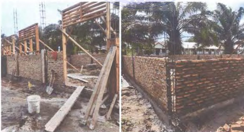
Gambar 3.10. Pekerjaan Pasangan Bata, Kusen Pintu Jendela, dan Kolom
