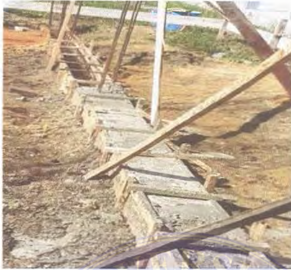
Gambar 3.9. Pekerjaan Bekisting dan Pengecoran
