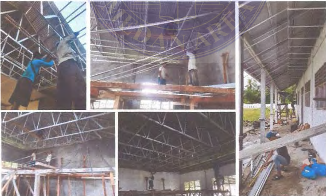
Gambar 3.20. Pekerjaan Rangka Plafond Baja Ringan
