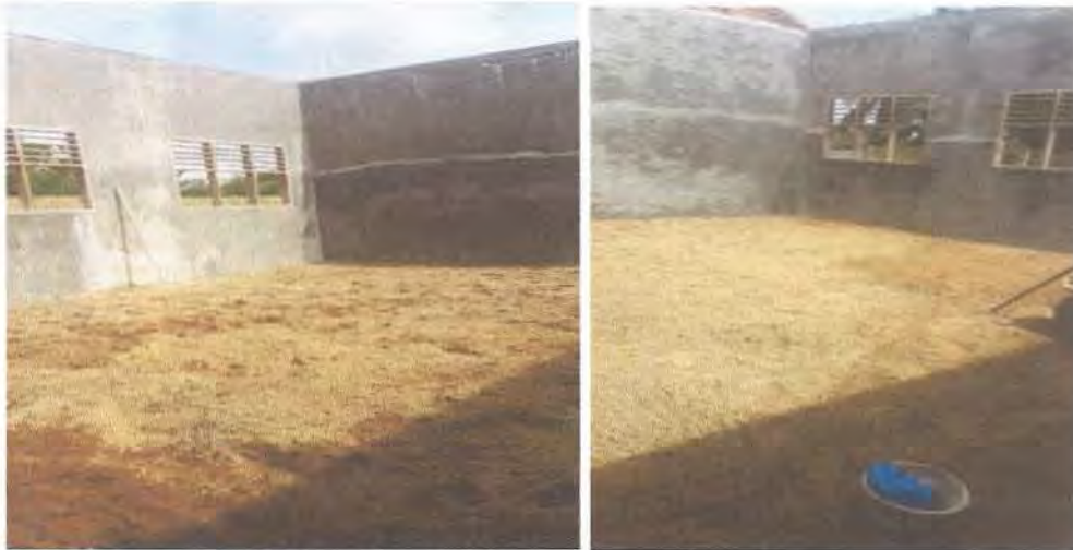
Gambar 3.14. Pekerjaan Timbunan Tanah
