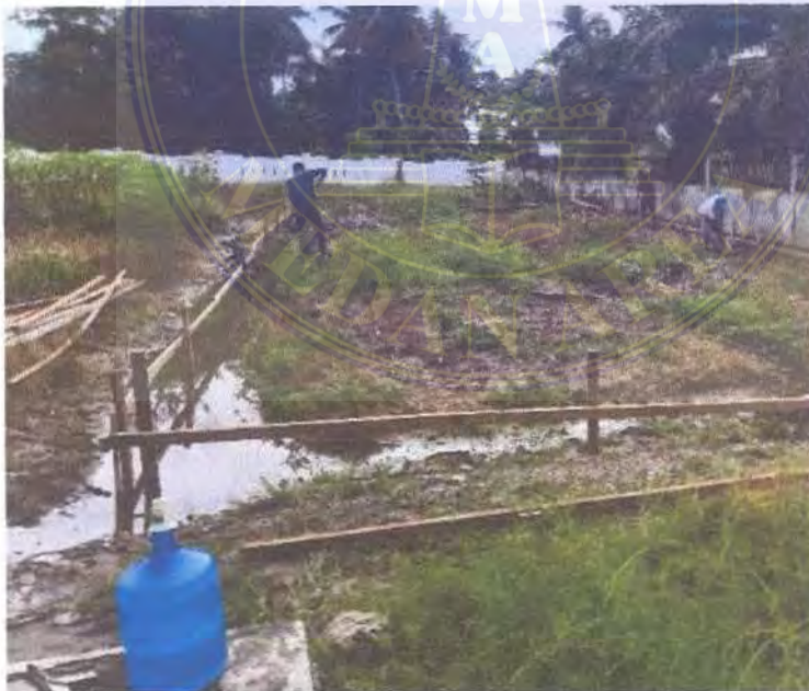
Gambar 3.3. Pekerjaan Bowplank
