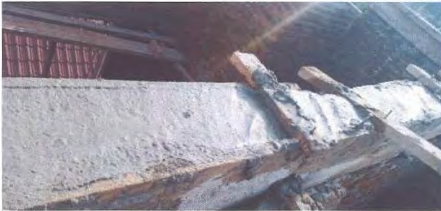
Gambar 4. Pengecoran ring balok
