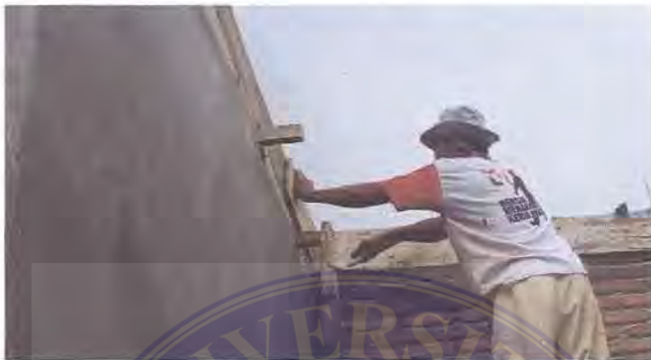
Gambar 3. Pemasangan bekisting
