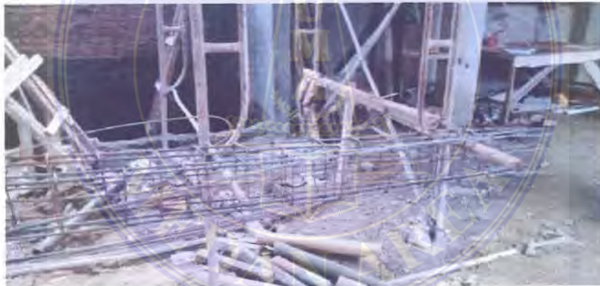
Gambar 1. Pembuatan beugel / sengkang
