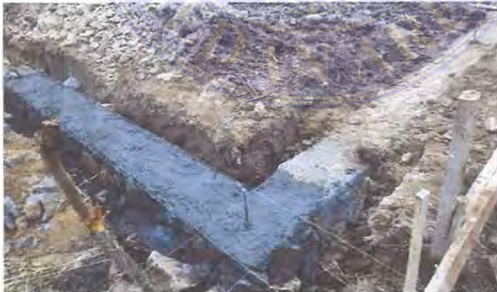
Gambar 3.9. Pekerjaan Bekisting dan Pengecoran
