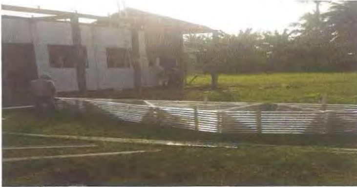
Gambar 3.16. Pekerjaan Perakitan Rangka Atap Kuda-Kuda Baja Ringan
