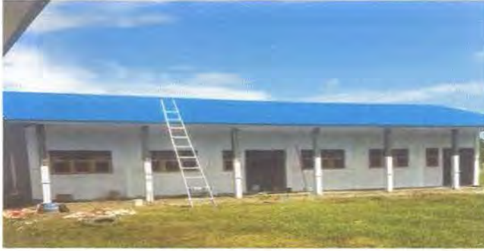
Gambar 3.19. Pekerjaan Atap Spandek
