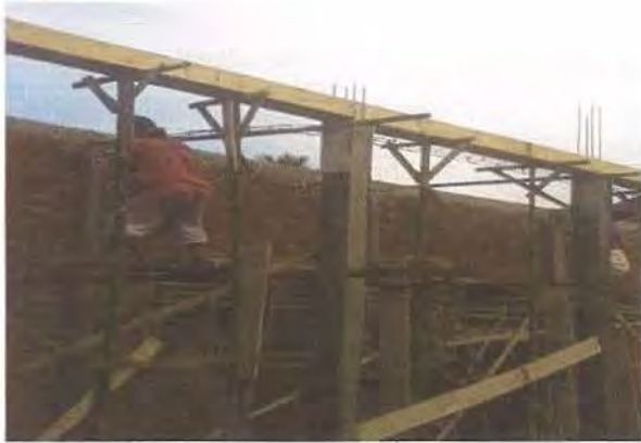
Gambar 3.11. Pekerjaan Ring Balok
