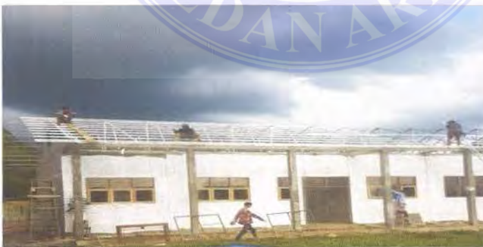
Gambar 3.18. Pekerjaan Pemasangan Kuda-Kuda Baja Ringan
