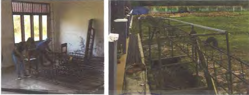
Gambar 3.8. Pekerjaan Pembesian Pondasi Tapak, Kolom, dan Sloof
