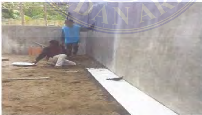
Gambar 3.24. Pekerjaan Pasangan Keramik (40x40)
