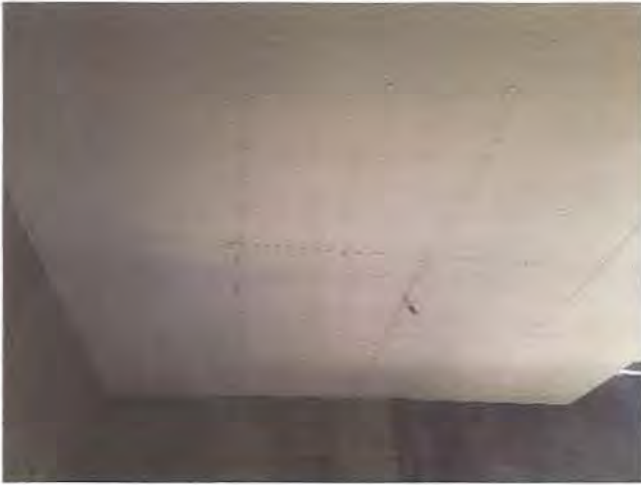
Gambar 3.21. Pekerjaan Plafond Gypsum
