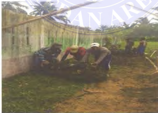
Gambar 3.2. Pengukuran dan Pembersihan Lokasi Pekerjaan
