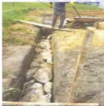
Gambar 3.5. Pekerjaan Pasangan Pondasi Batu Belah atau Pondasi Penerus
