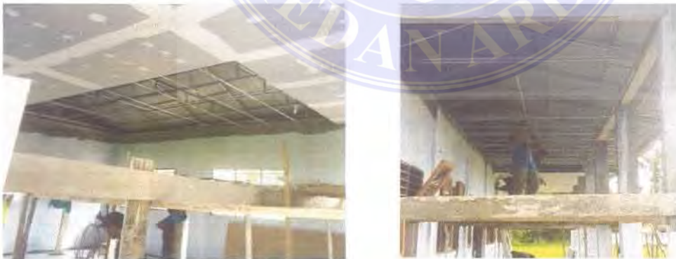
Gambar 3.20. Pekerjaan Rangka Plafond Baja Ringan
