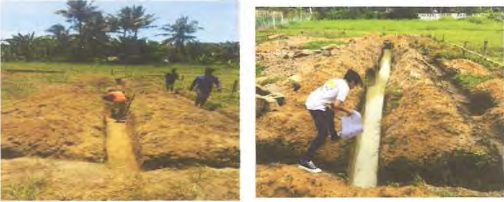
Gambar 3.4. Pekerjaan Galian Pondasi
