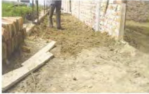
Gambar 3.14. Pekerjaan Timbunan Tanah
