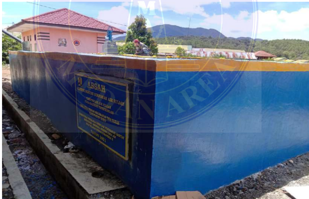
Foto Bak Tampungan ABSAH Selesai Dikerjakan
