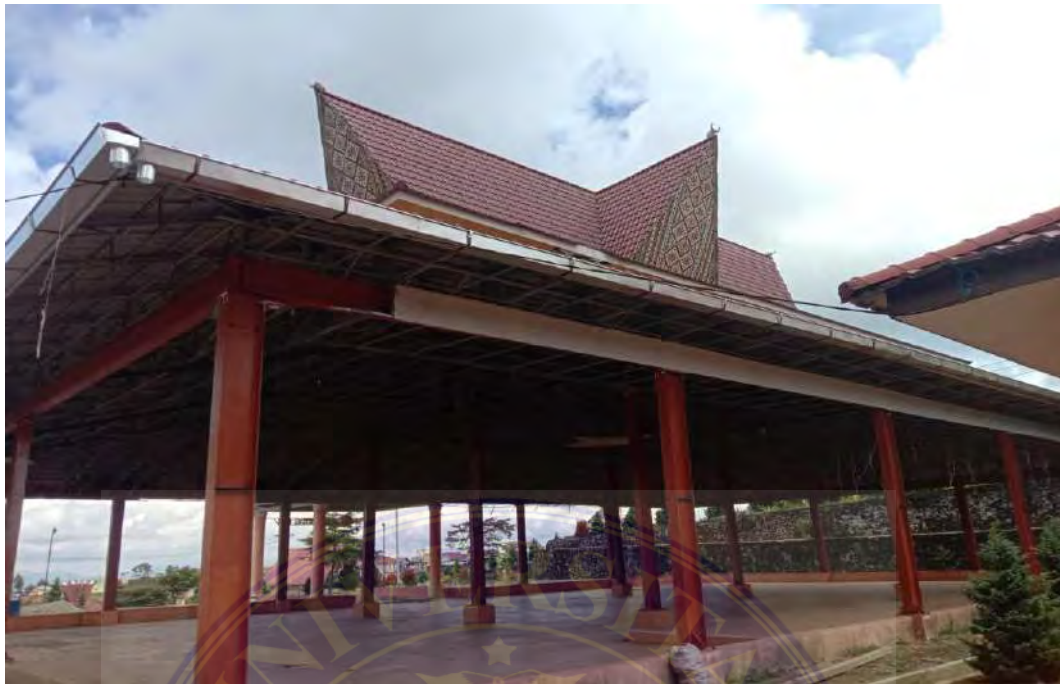
Foto Pemasangan Talang Air Selesai Dikerjakan
