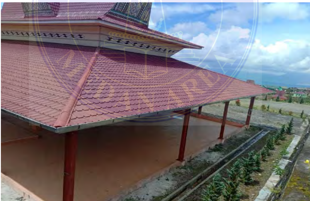
Foto Jambur Selesai Dipasang Talang Air
