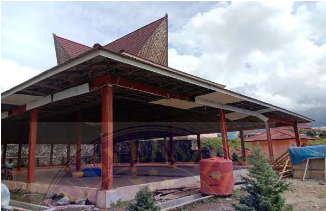
Foto Jambur Sebelum Dipasang Talang Air
