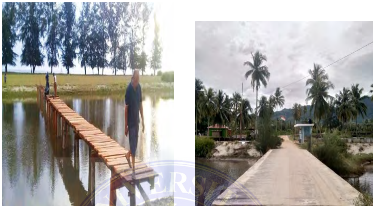
Gambar 9: gambar pembangunan gapura Pantai Indah Sibintang
