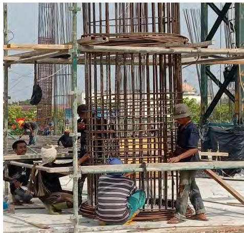
Gambar 2.8 Penulangan Kolom Bulat
