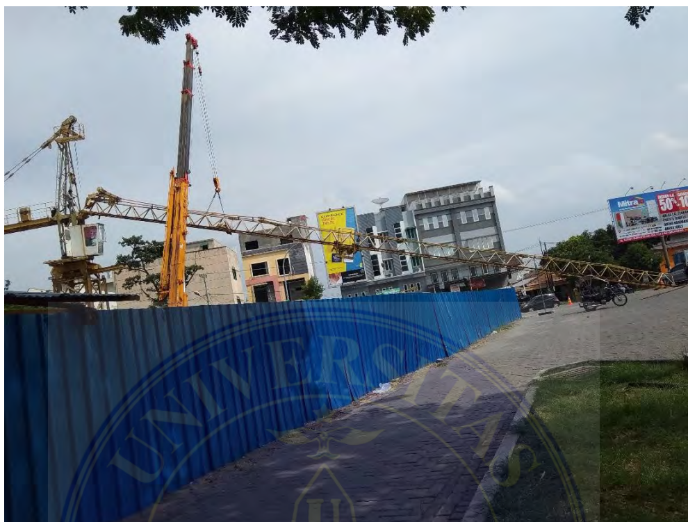
Gambar 1 Pemasangan Jib Tower Crane
