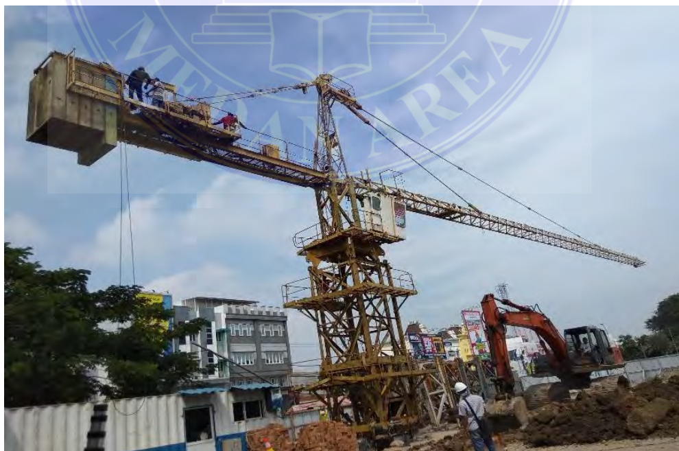
Gambar 4 Pemasangan Komponen Tower Crane Telah Selesai dan Siap Digunakan
