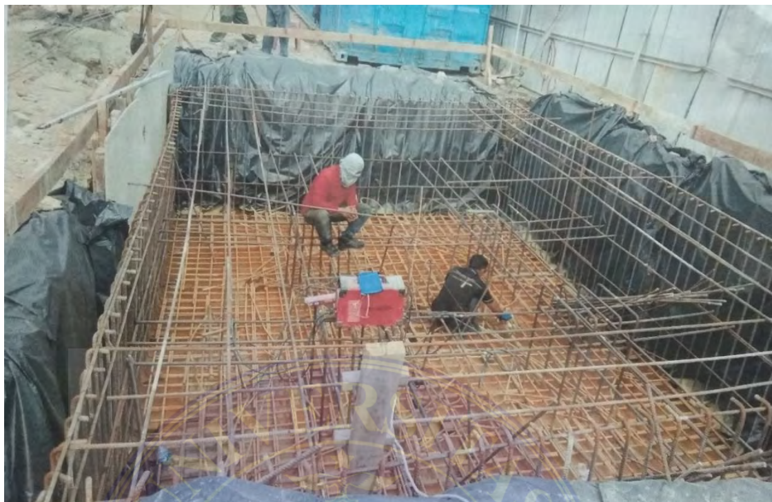
Gambar 5 Pemasangan Tulangan Pondasi pada Tower Crane
