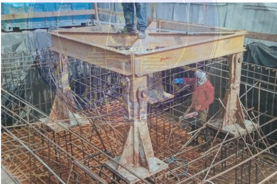
Gambar 6 Pemasangan Anchor atau Fine Angel Tower Crane
