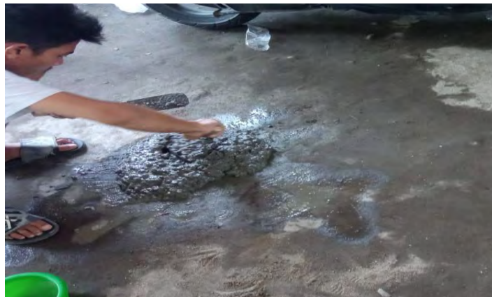
Gambar 3. 10. Pengadukan campuran agregat beton
