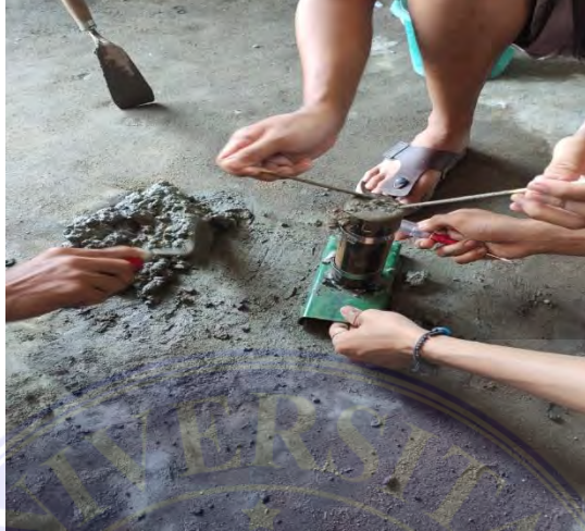
Gambar 3. 11. Agregat beton yang dituangkan ke dalam cetakan
