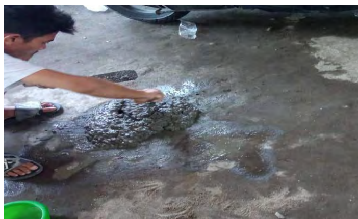
图3.10. 混凝土骨料混合物的搅拌
