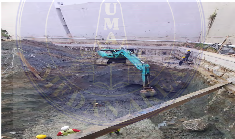
Gambar 6 Proses Penggalian 1 kedalaman 4 Meter
