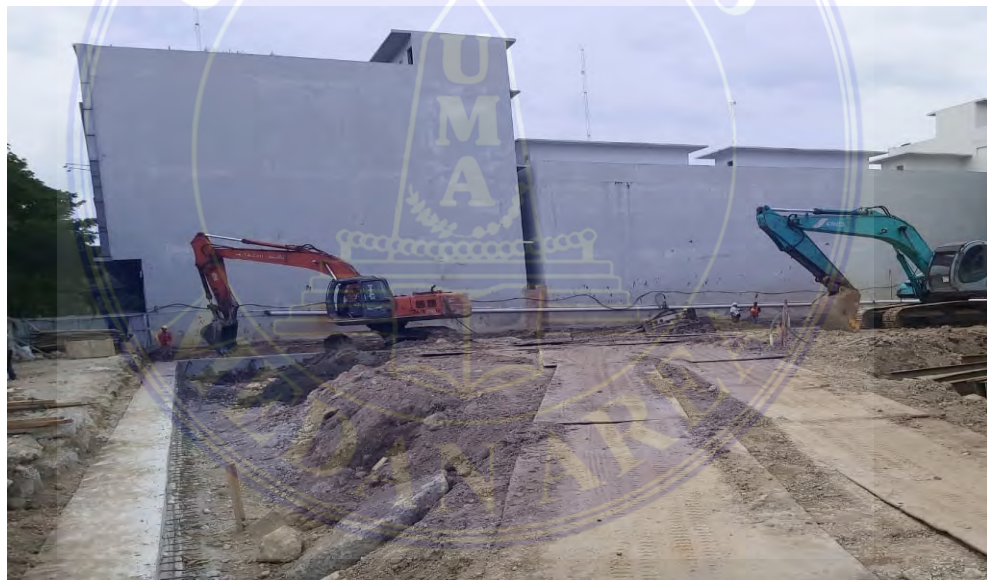
Gambar 4 Capping Beam Selesai di Cor
