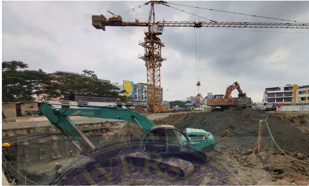
Gambar 5 Proses Penggalian 1 kedalaman 2 Meter
