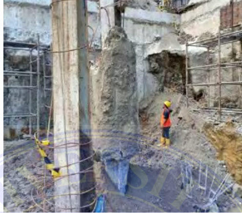
Gambar 3.2 Pondasi Bore Pile Sumber : Dokumentasi Lapangan
