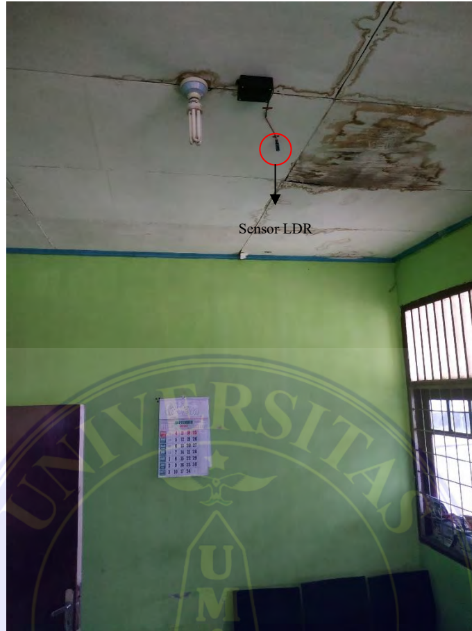
Gambar 3.15 : Letak sensor LDR di ruangan asisten manager pemasaran
