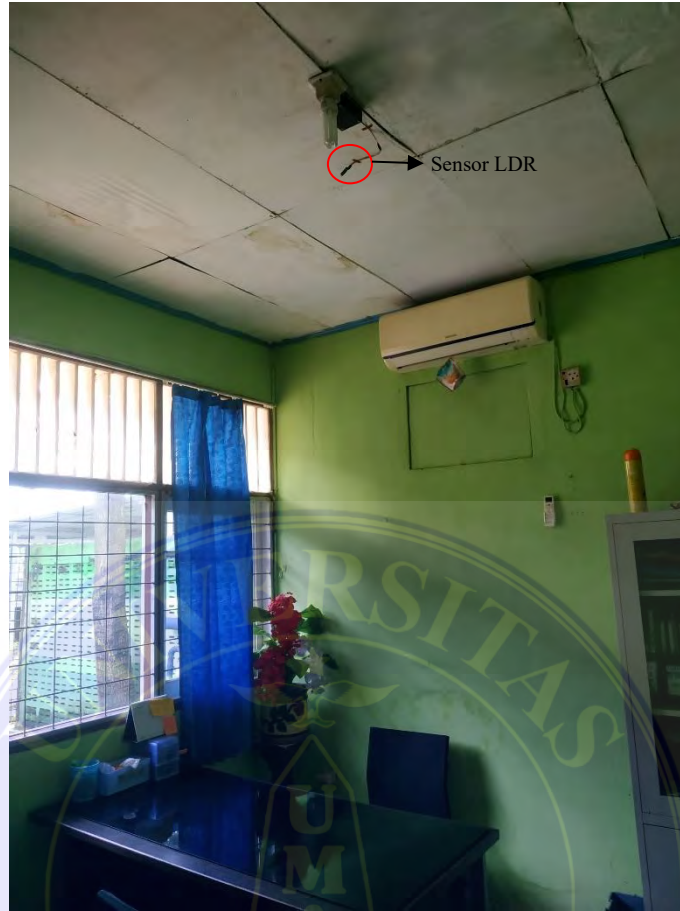
Gambar 3.13 : Letak sensor LDR pada ruangan manager pemasaran
