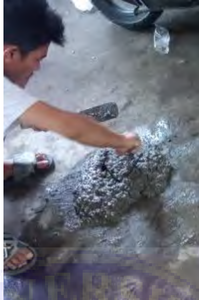
Gambar 3. 9. Pencampuran Agregat Beton
