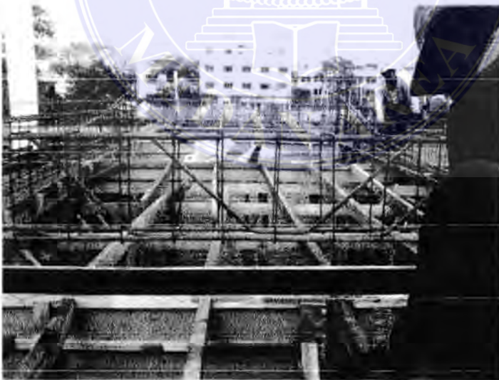
Gambar 2.a Pembesian dengan sistem Trombol pada pembalokan
