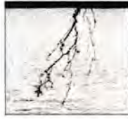
Gambar 2.3 Retak antara kristal pada korosi regangan
