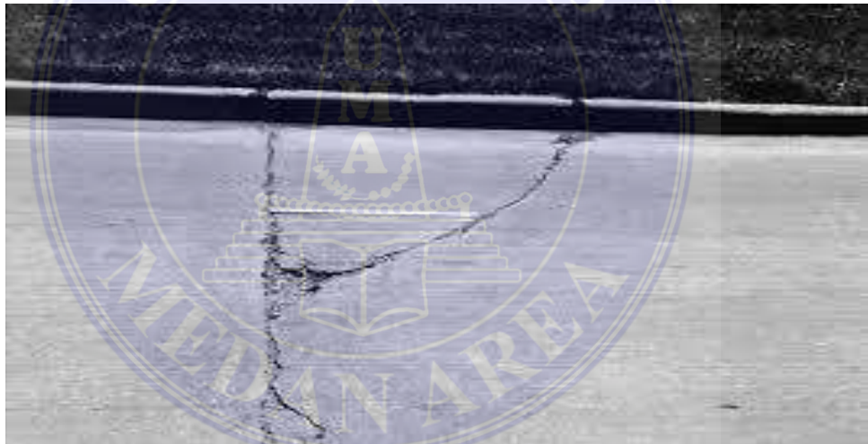
Gambar 3. Retak Setempat (Nurul Fadillah, 2013)
