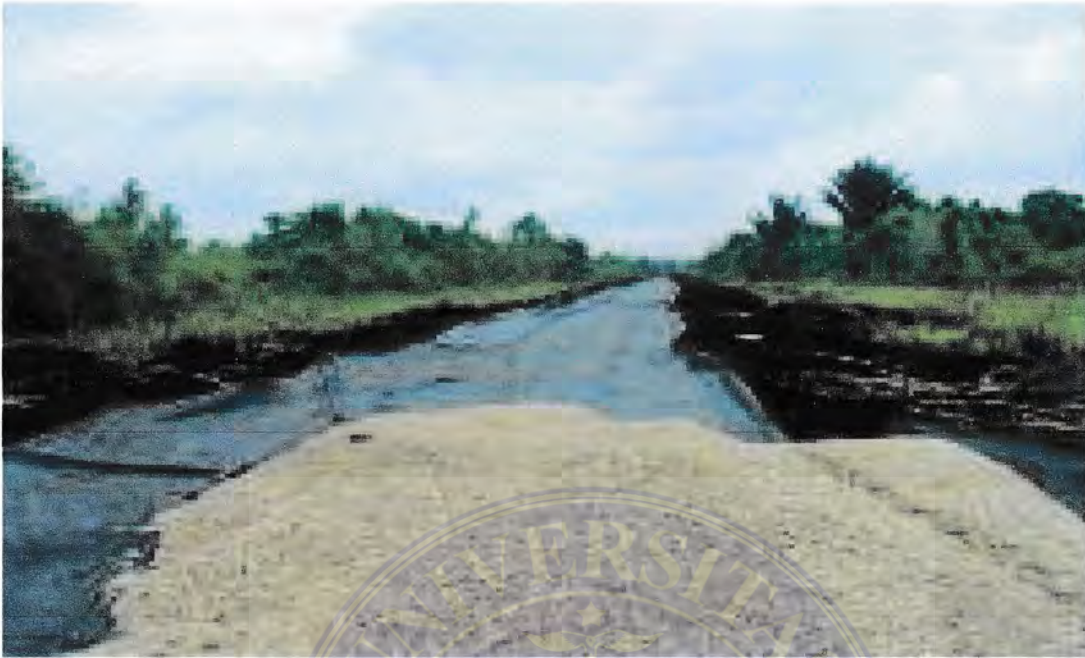
Gambar 2.8. Penyebaran Material subbase course di atas geotekstil yang sudah di bentangkan (Sumber : www.google.com )
