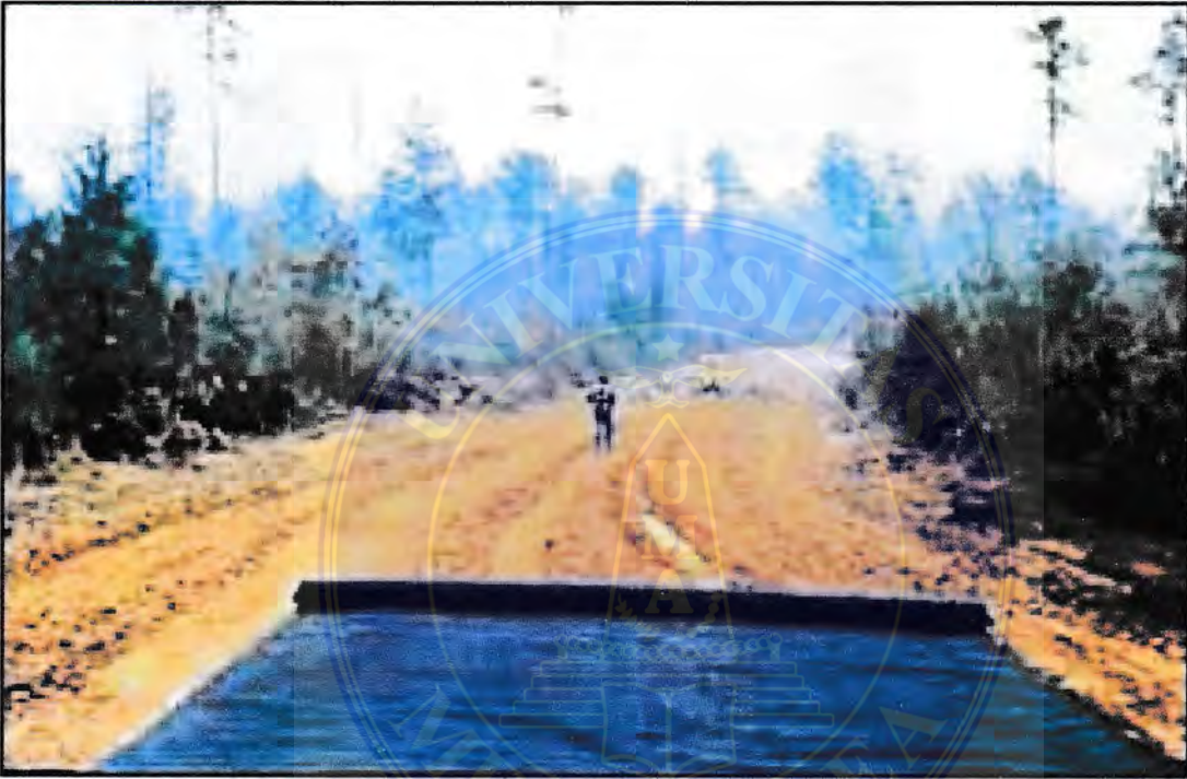
Gambar 2.7. Pemasangan Geotekstil pada tanah lunak untuk perkerasan jalan (Sumber : www.google.com )
