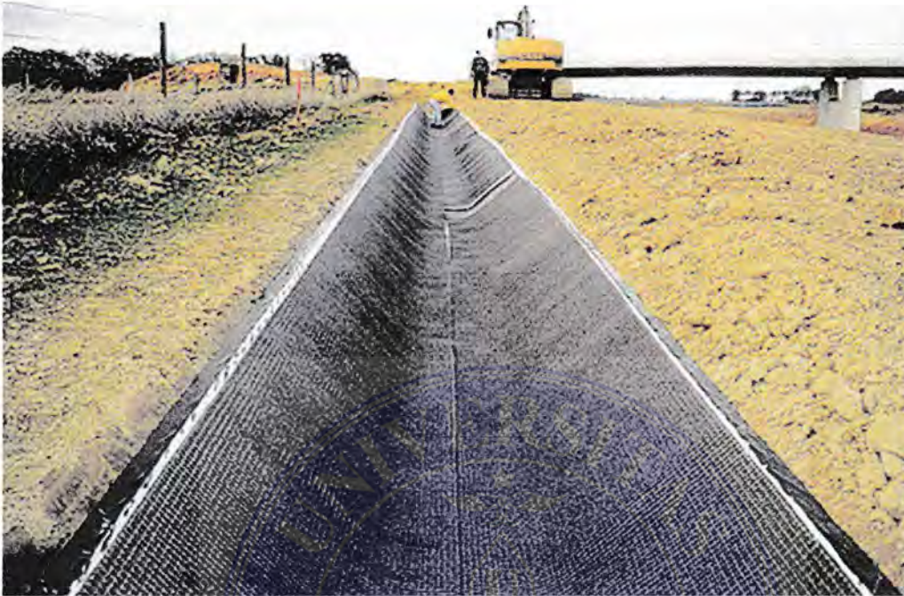
Gambar 2.6 Penggunaan Geotekstil sebagai Filter dan drainase (Sumber : Definisi dan Fungsi Geotextile Non Woven , ( www.google.com ))
