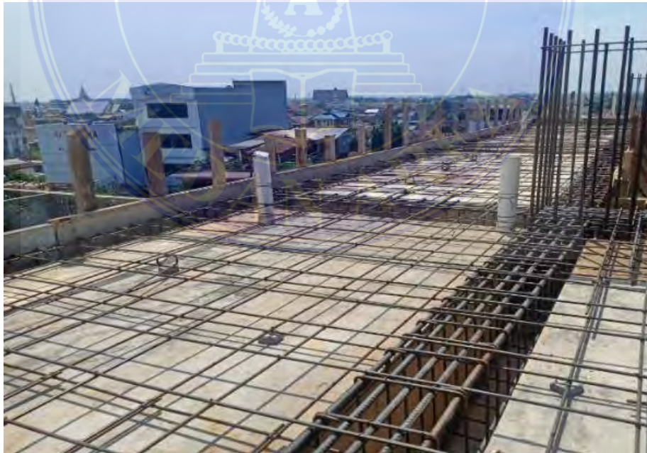
Gambar 3.5 Bekisting dan Penulangan Pelat Lantai Konvensional ( Existing ) Sumber : Dokumentasi Proyek, 2021
