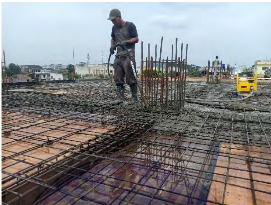
Gambar 3.6 Pengecoran Pelat Lantai Konvensional ( Existing ) Sumber : Dokumentasi Proyek, 2021
