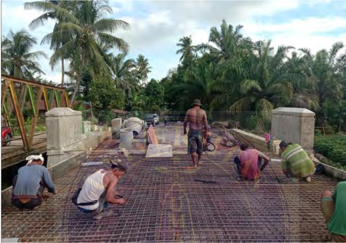
Gambar Penulangan slab lantai
