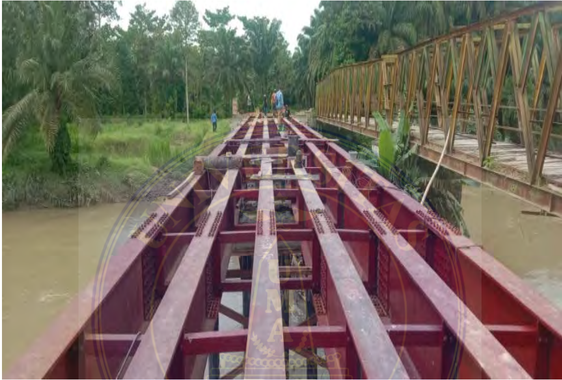
Gambar Pemasangan Gelagar dan Ssambungan gelagagar
