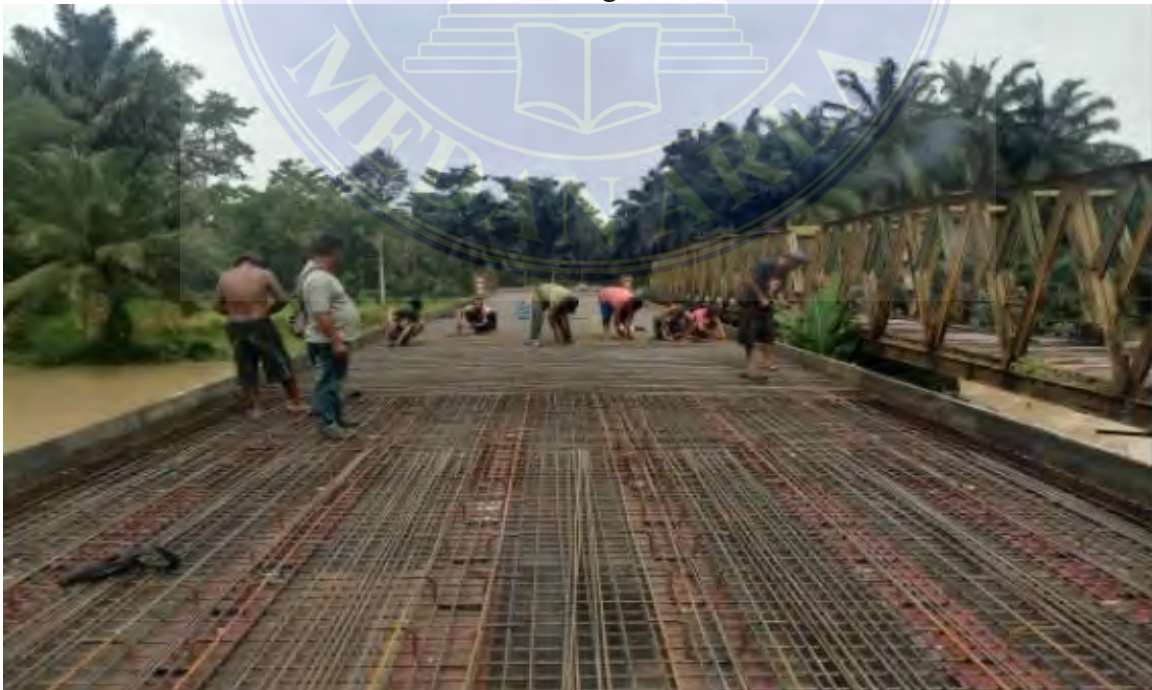
Gambar Penulangan slab lantai
