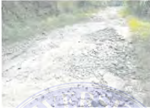
Gambar. 2.8 Pelepasan butir (raveling)
