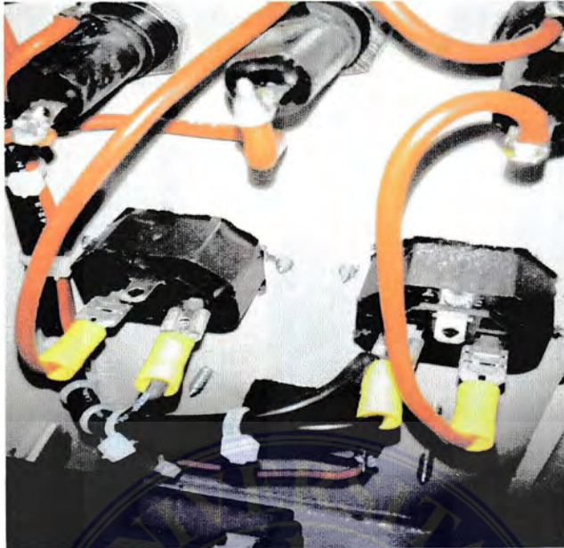
Gambar 3.11. Pemasangan kabel saklar, fuse dan cok fimate
