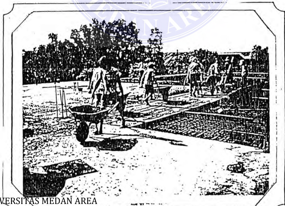
Gambar 3 : PENGECORAN PELAT ATAP.
