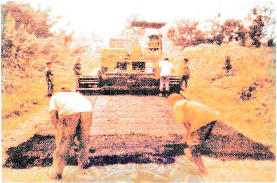
Gambar 1.2 Penghamparan dengan Asphalt Finisher Sumber Dari Lapangan tahun 2008
