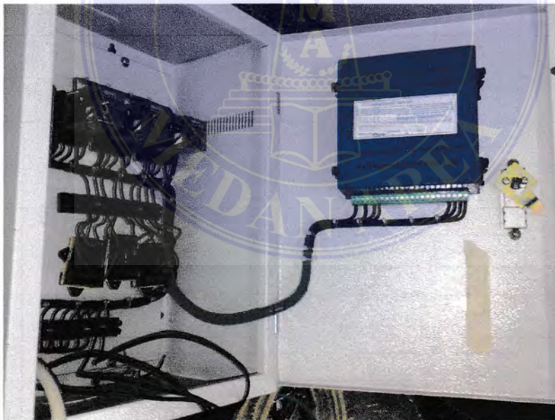
(c) Tampak Dalam Alat Pengaturan Otomatisasi Kapasitor Bank
