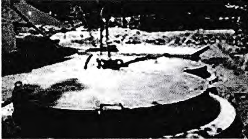
Gambar 2.5.2.a.model unit gas bio sebagian tangki pencerna di bawah permukaan tanah
