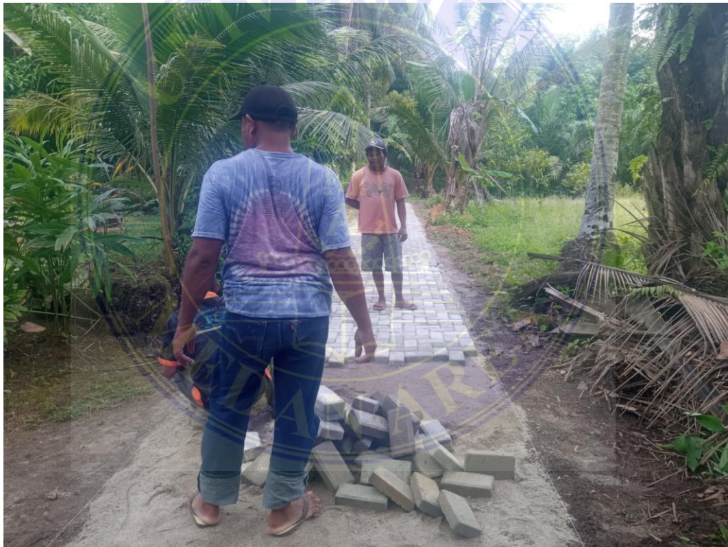
Photo Kegiatan Pemasangan Paving Block di Salah Satu Jalan Desa Kotasan
