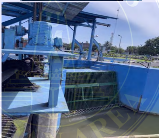
Gambar Intake yang di sebutkan dalam pengolahan air
