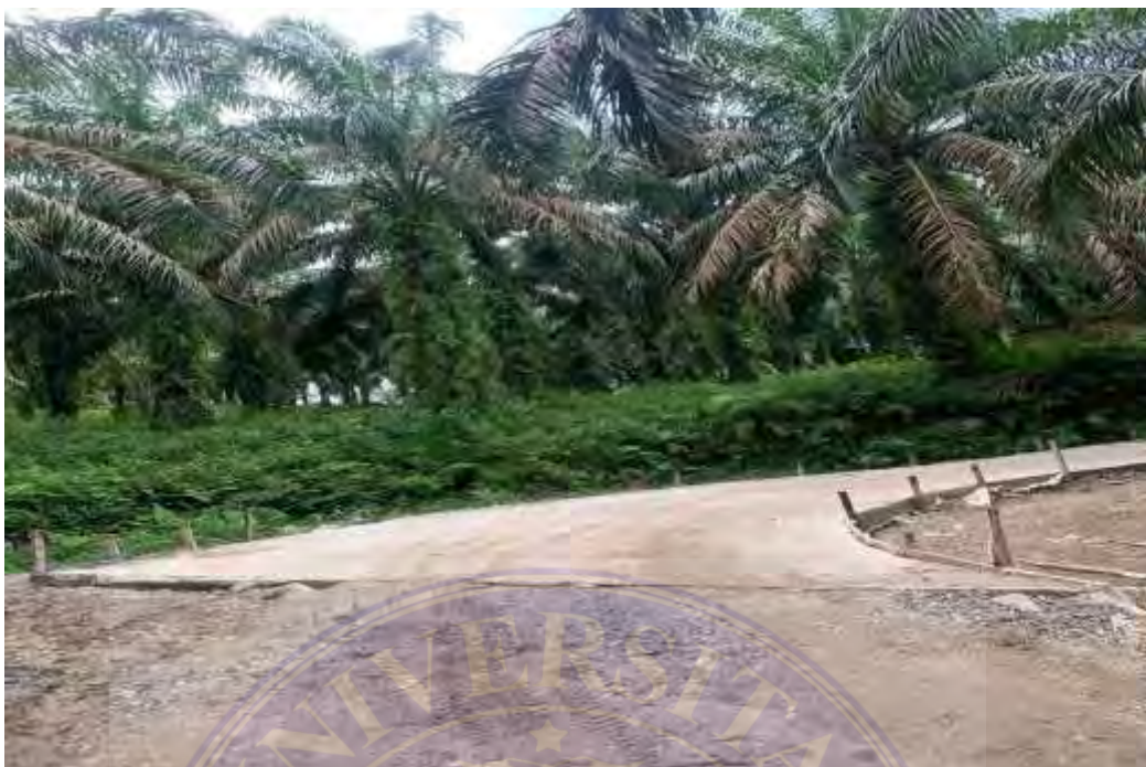
Dokumentasi Infrastruktur Jalan Yang Hampir Selesai Di Perbaiki Di Desa Bangun Rejo
