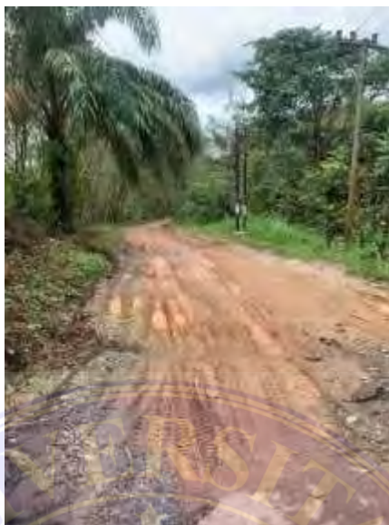
Gambar 1.1 Jalan Desa Bangun Rejo
