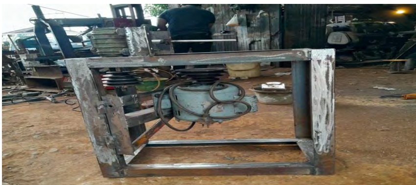
Lampiran 1. Proses Pemasangan Gearbox Dan Motor Listrik
