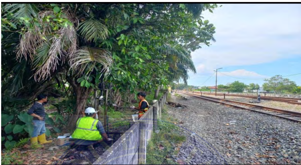
Gambar 1. Proses Pengujian tanah menggunakan Tes Sondir Sumber : Data Lapangan
