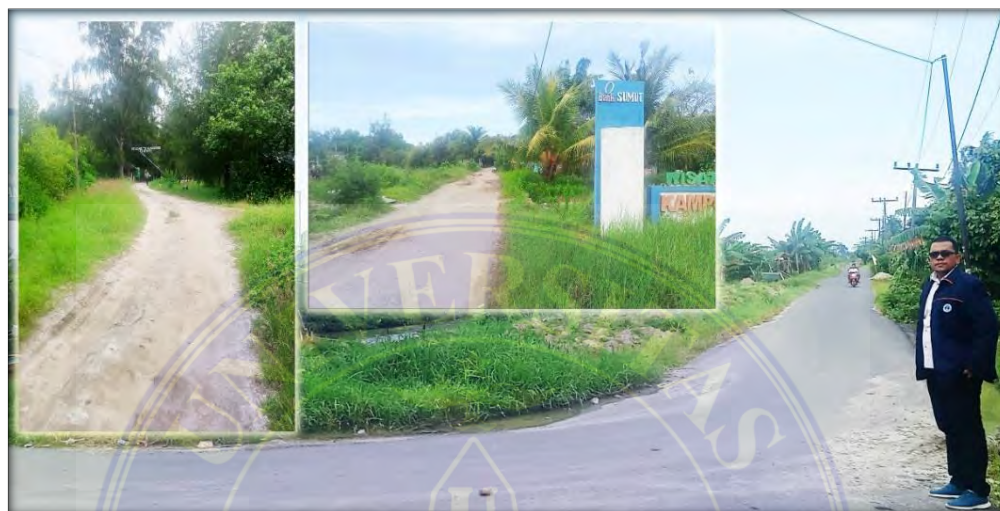
Gambar 22. Akses jalan menuju lokasi Wisata Mangrove Kampoeng Nipah (Sumber : Peninjauan lapangan, Januari 2023)
