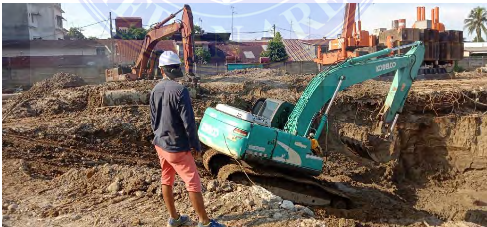
Gambar 15 Dokumentasi penggalian basement
