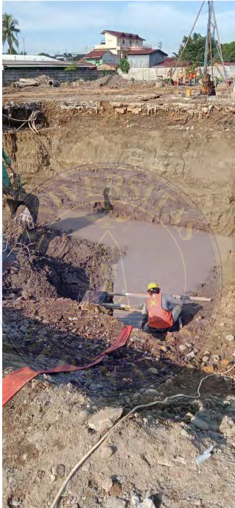
Gambar 12 Dokumentasi penggalian basement
