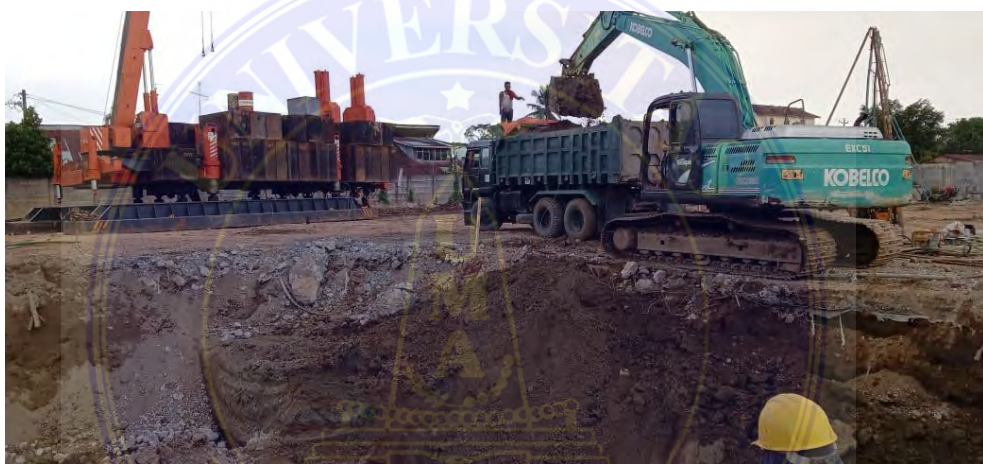
Gambar 10 Dokumentasi penggalian basement
