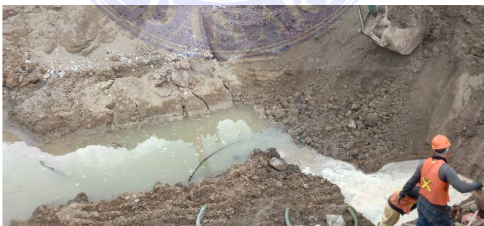
Gambar 11 Dokumentasi penggalian basement
