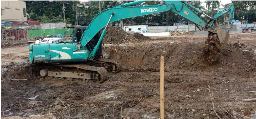
Gambar 9 Dokumentasi penggalian basement
