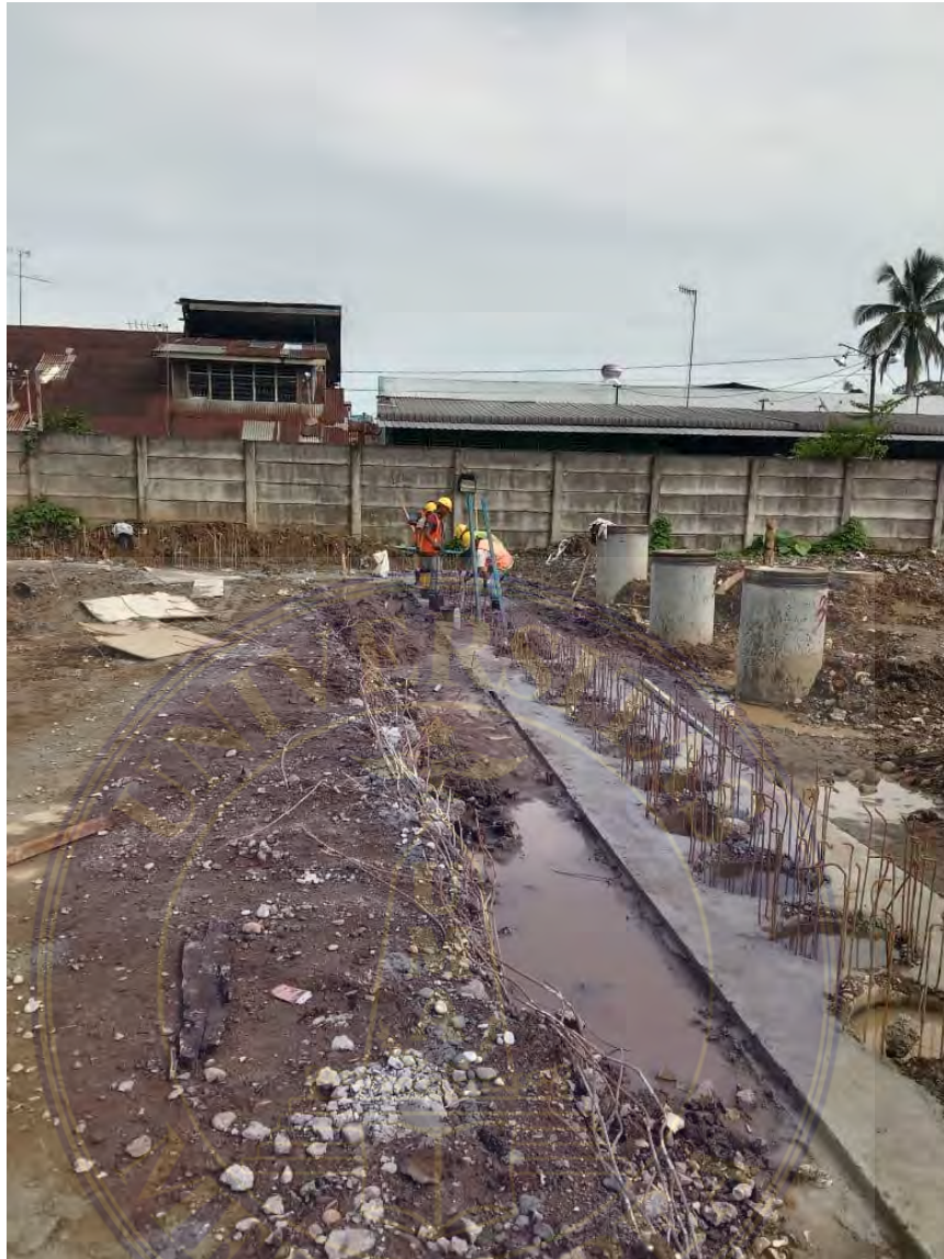
Gambar 17 Dokumentasi pemancangan spun pile
