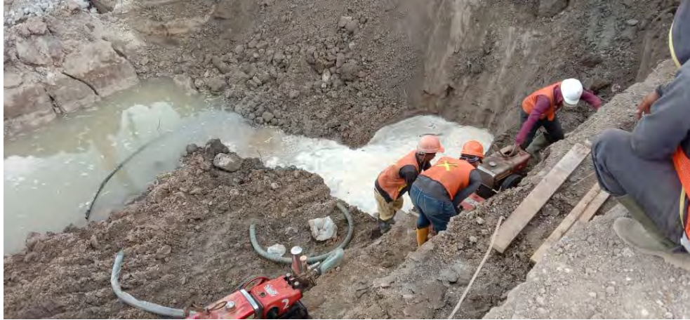
Gambar 13 Dokumentasi penggalian basement
