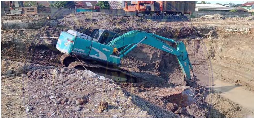
Gambar 14 Dokumentasi penggalian basement
