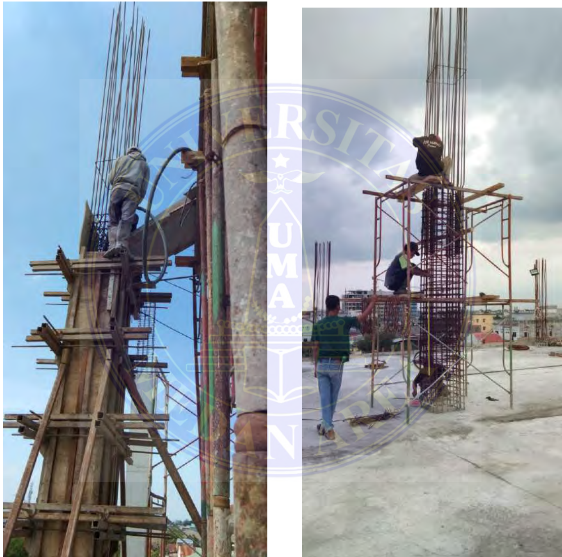
Gambar 5. Tampak Pembesian Kolom dan Pengecoran Kolom di Lantai 3
