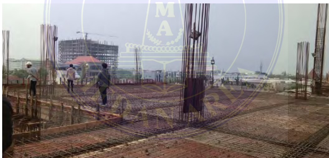
Gambar 7. Tampak Pembesian Plat Lantai di Lantai 3
