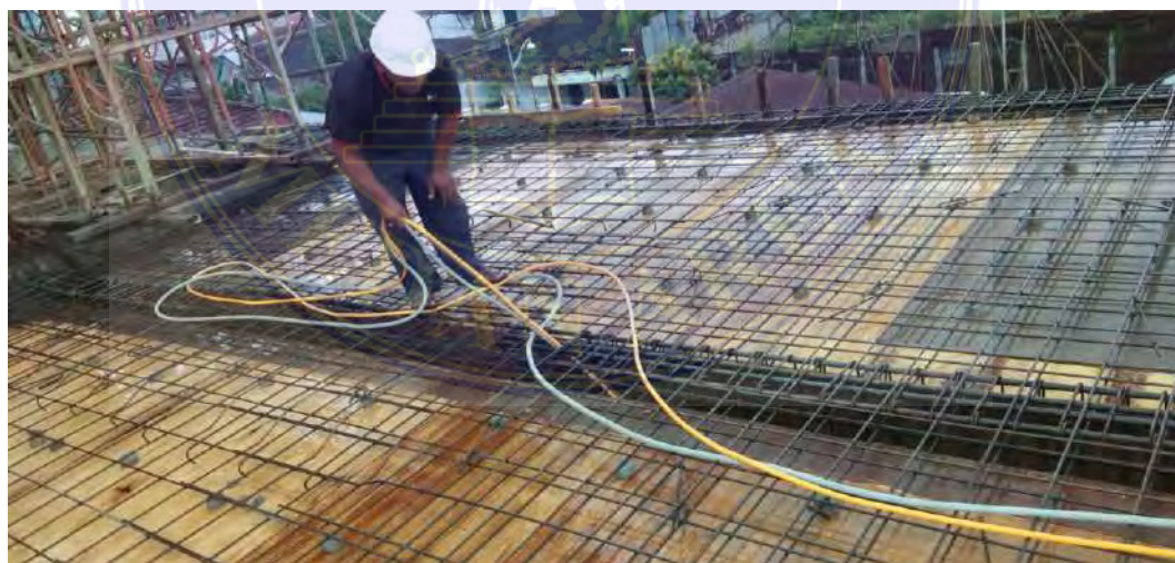
Gambar 4. Tampak Pembersihan Material Untuk Persiapan pengecoran
