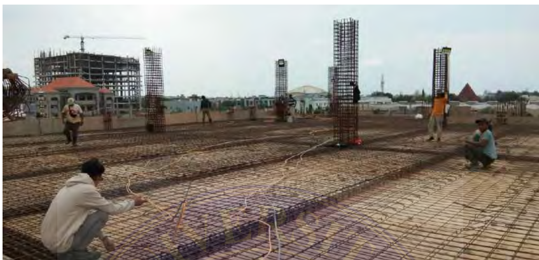
Gambar 3. Tampak Pembesian Pada Plat Lantai
