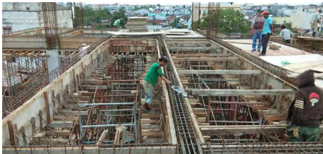
Gambar 6. Tampak Pembesian Balok di Lantai 3
