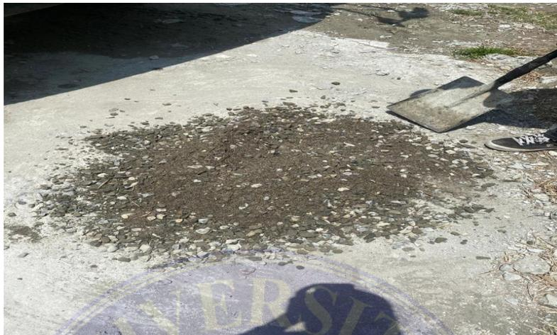
Gambar 5. Proses pencampuran pasir, kerikil, dan semen
