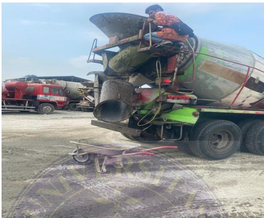
Lampiran 19. Proses Penuangan Adukan Beton *Ready Mix*
