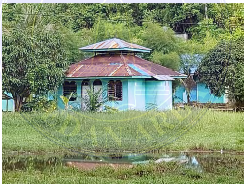
Gambar 5.8. Kondisi Mushola Di Objek Wisata Pantai Kalangan
