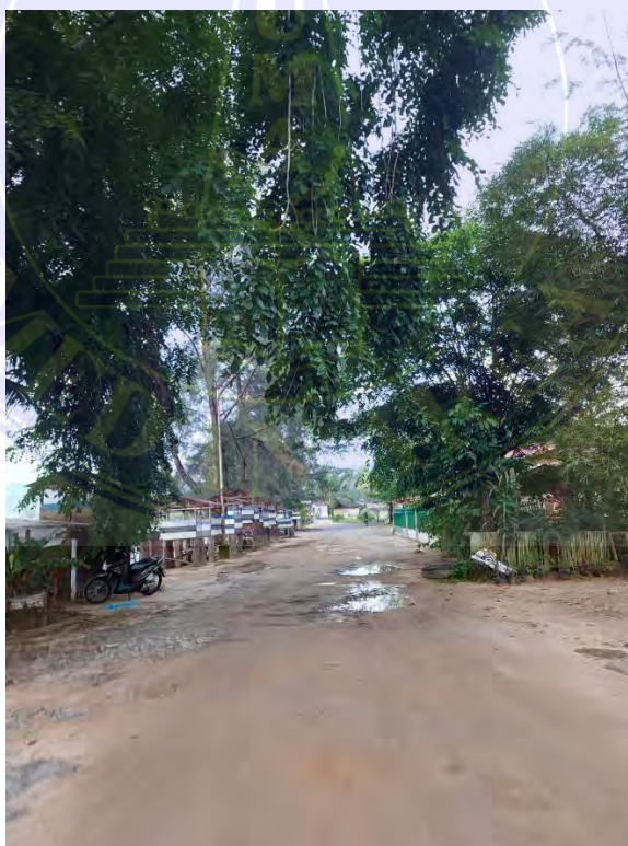
Gambar 5.6. Kondisi Jalan Di Objek Wisata Pantai Kalangan
