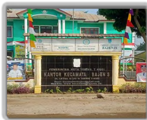
Kantor Kecamatan Bajenis
