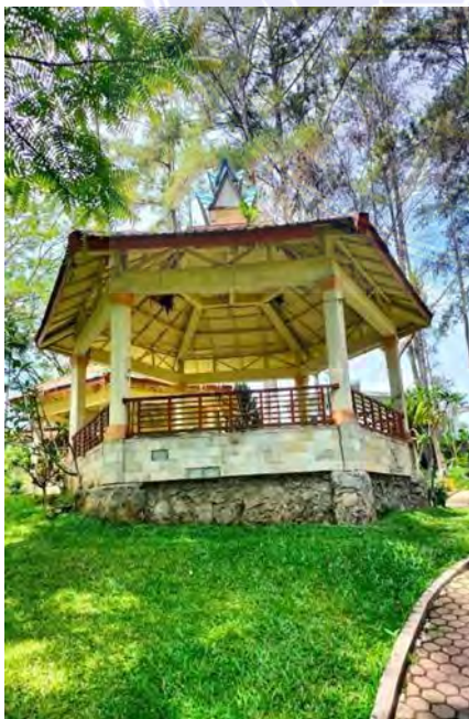
Tempat berteduh yang sudah mulai rusak di TWI
