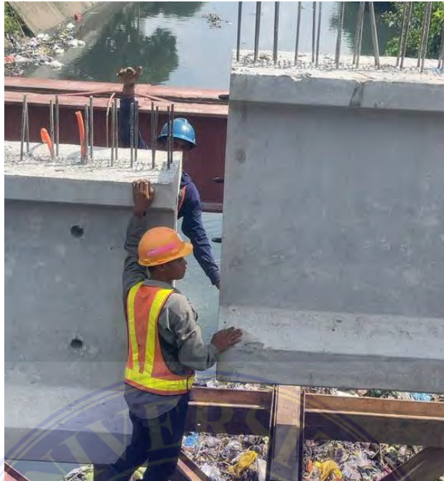
Gambar 3. Proses penyambungan segmen balok prategang Sumber : Data Lapangan
