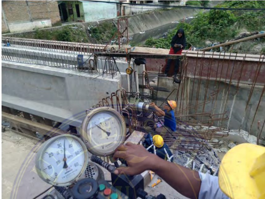
Gambar 1. Proses stressing balok prategang Sumber : Data Lapangan
