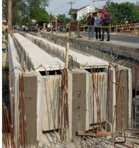
Gambar 13. Balok Gelagar tipe-I girder (Dokumentasi lapangan)
