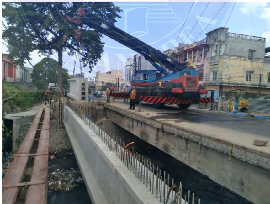
Gambar 2. Proses erection balok prategang Sumber : Data Lapangan
