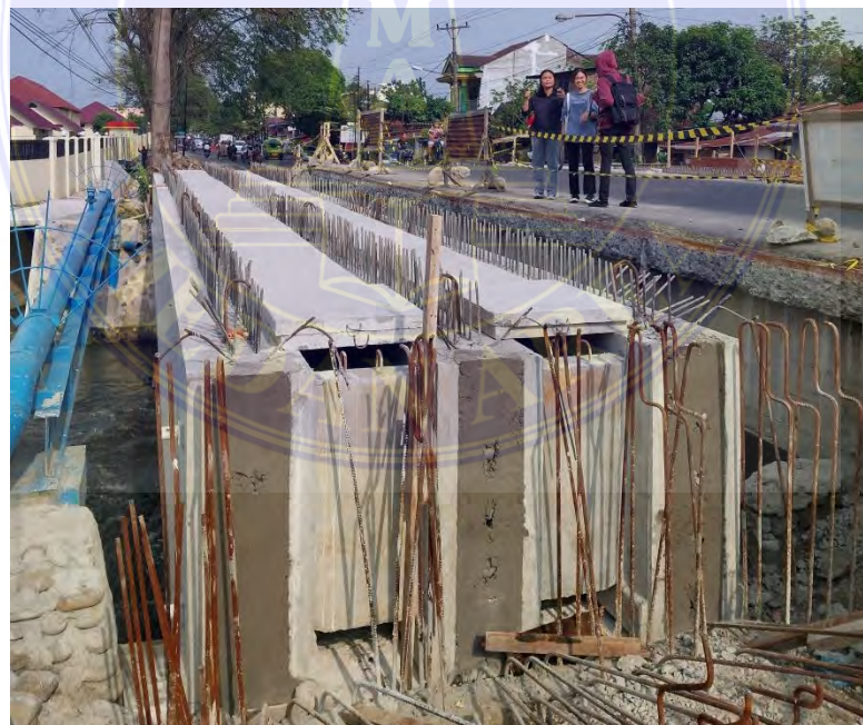
Gambar 4. Balok Prategang setelah dipasang dan di stressing Sumber : Data Lapangan
