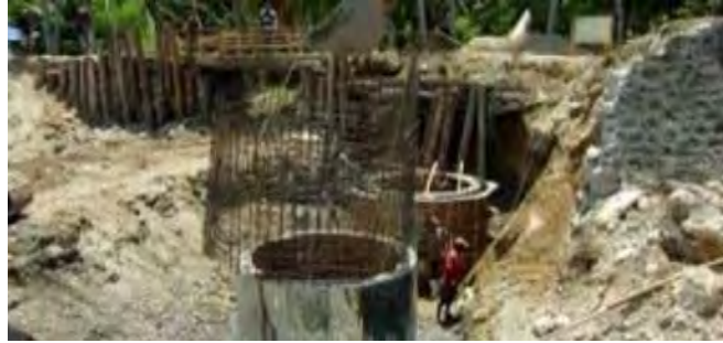
Gambar 3. Pondasi sumuran (Rekayasa Pondasi, Elmi Rahmatika, 2022)
