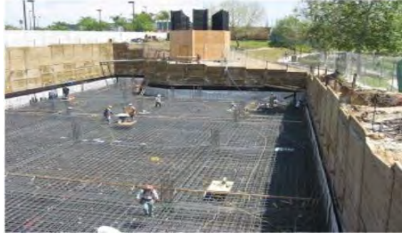
Gambar 2. Pondasi rakit (Rekayasa Pondasi dangkal, Darwis Syahrul Sariman, 2022)
