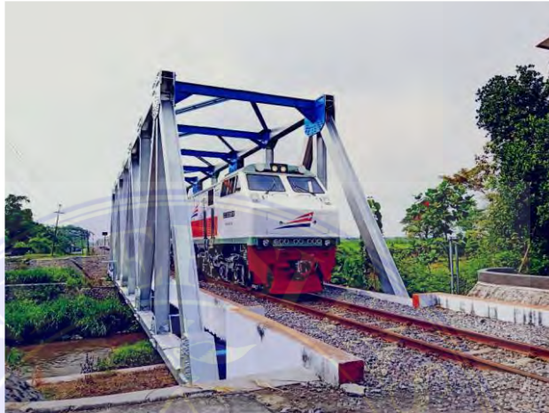
Gambar 11. Jembatan Jalan Kereta Api (Hafizha, 2021)
