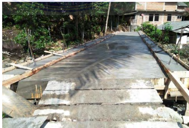
Gambar 4. Jembatan Beton (Hafizha, 2021)
