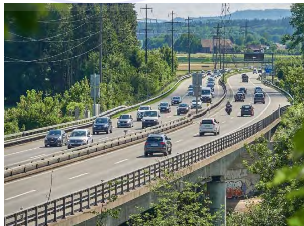
Gambar 10. Jembatan Jalan Raya (Hafizha, 2021)
