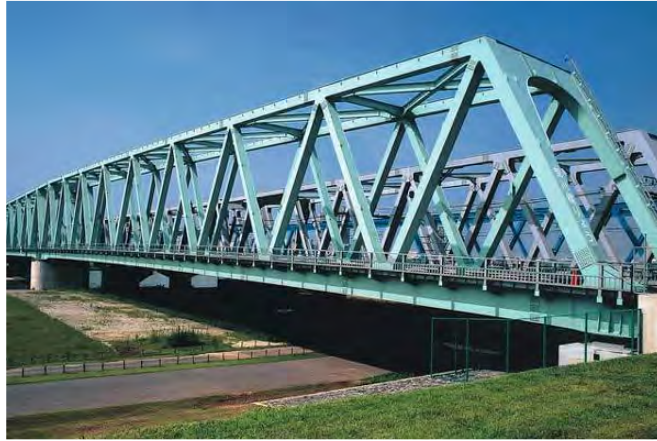
Gambar 6. Jembatan Baja (Hafizha, 2021)
