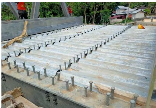
Gambar 12. Pelat Bondek (Proyek Penggantian Jembatan Idano Eho)
