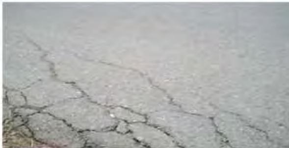
Gambar 9. Retak Pinggir (Keselamatanjalan, 2017)
