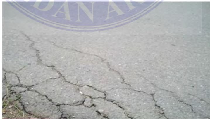
Gambar 3. Retak Pinggir *Edge Crack* (Binar Maga No. 03/MN/B/1983)
