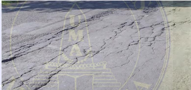
Gambar 14. Penurunan pada bekas penambalan *Untlitas Utility Cut Depression* (Binar Maga No. 03/MN/B/1983)
