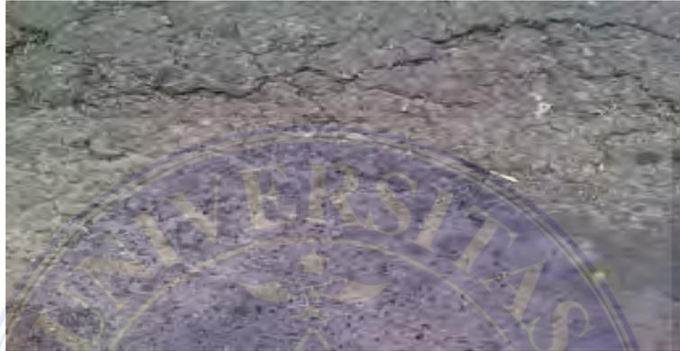
Gambar 12. Pelepasan Butir *Weathering/Raveling*
