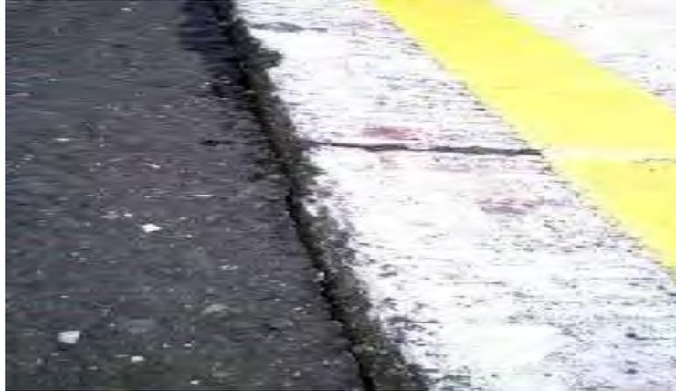
Gambar 5. Retak Sambungan Jalan *Lane Joint Cracks*
