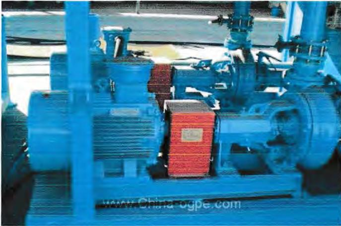
Gambar 3.2. pompa sentrifugal
