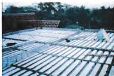
Gambar 66. Pemasangan dak beton
